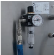
Druckluftanschluss. Druckluft wird benötigt!
